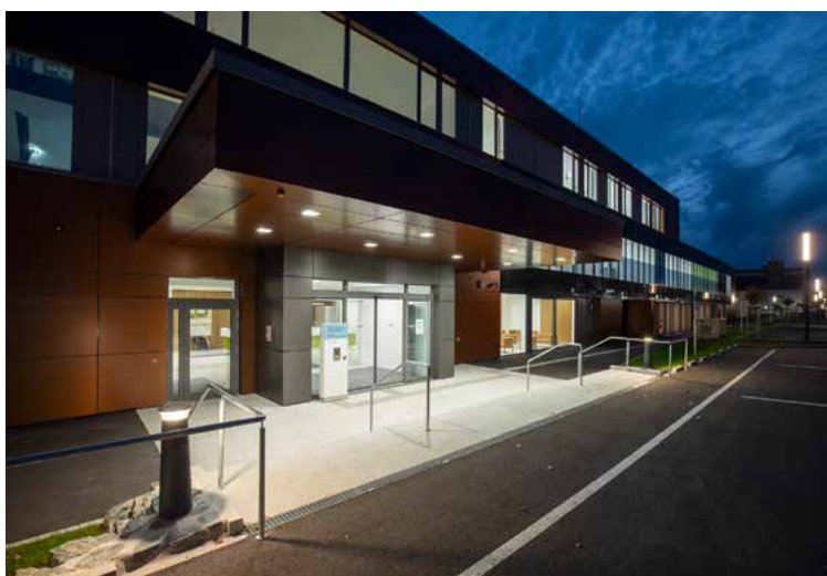
Die Bauzeit für die neue Psychiatrie betrug etwas mehr als drei Jahre.
