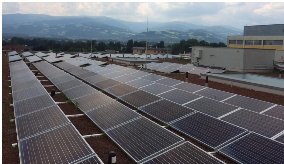
Bild 3: PV Anlage LKH Wolfsberg
