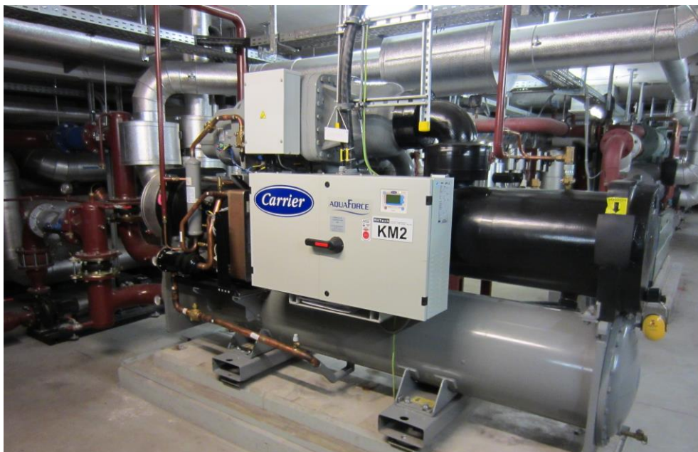
Bild 4: Kälteanlage Carrier LKH Villach
