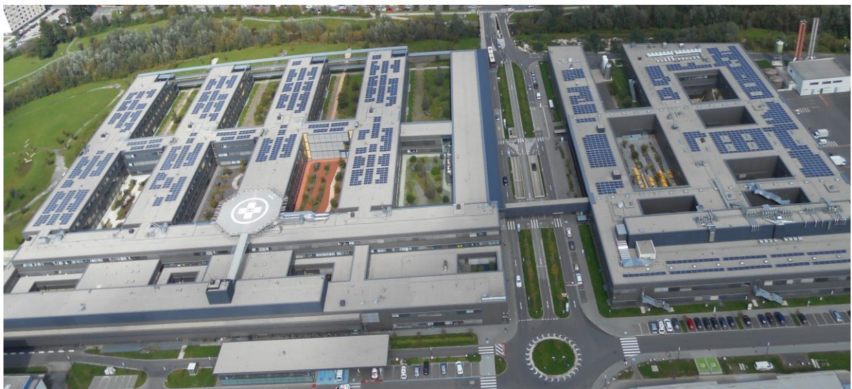
Bild 2: PV Anlage 570 kWp Klinikum Klagenfurt
