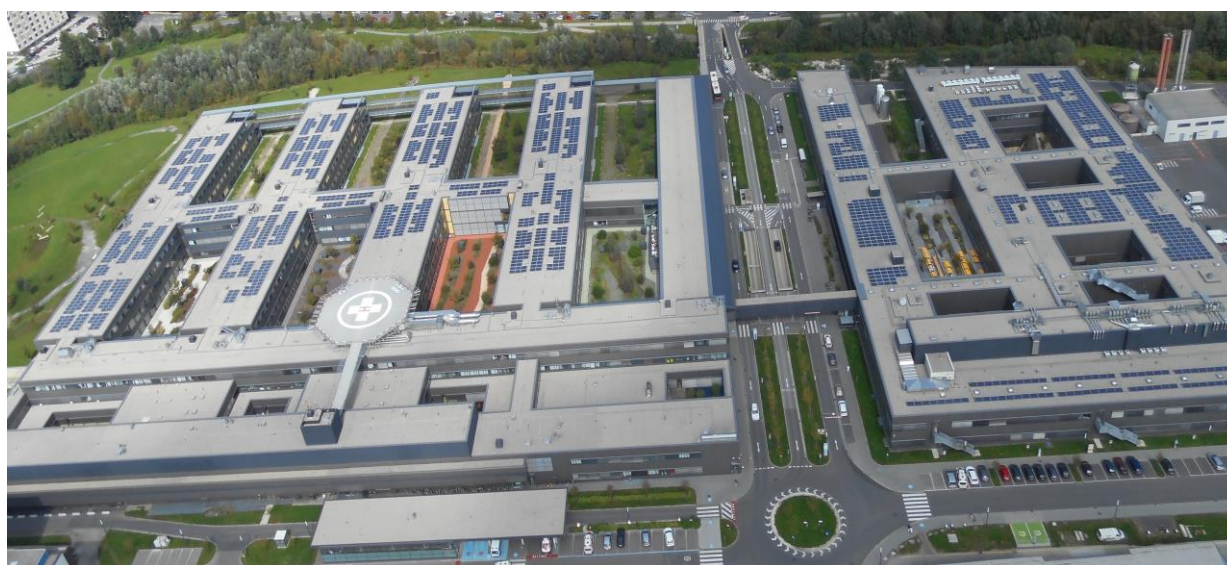
Bild 2: PV Anlage 570 kWp Klinikum Klagenfurt
